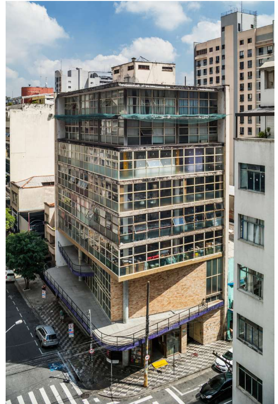
Sede do Instituto dos Arquitetos do Brasil, São Paulo, depois do restauro. (Foto: Nelson Kon, 2015)
