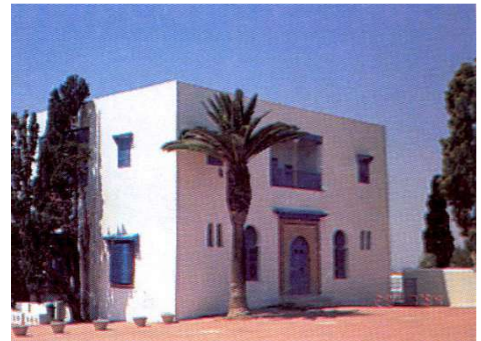
Sidi Bou Saïd Palais du Baron d'Erlanger. Façade Belvédère en cours restauration. Façade Belvédère après restauration.
