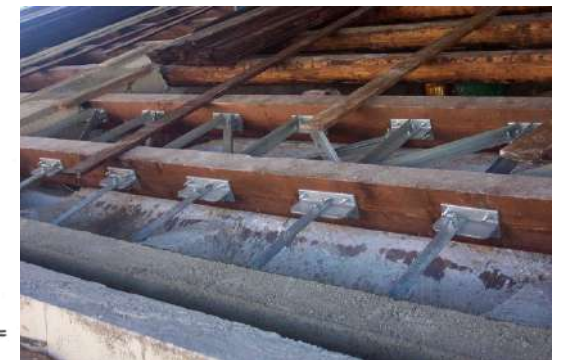
Fig. 5. Trave reticolare parallela alla parete di facciata.
