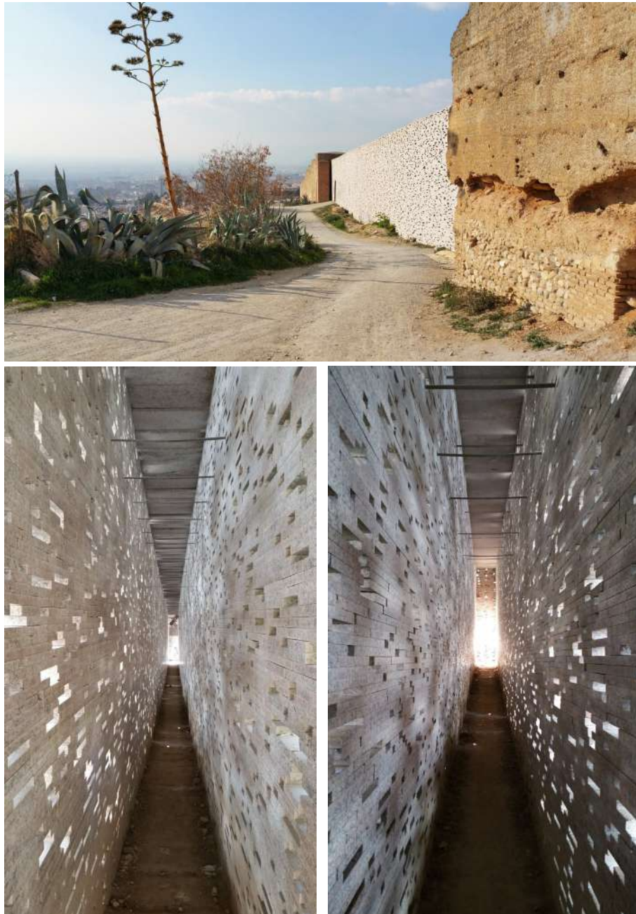
Fig. 1. Granada, Spagna, muraglia Nazarí nell'Alto Albaicín, accostamento del nuovo muro di granito Rosa Porriño con il vecchio muro di tapial, progetto arch. Antonio Jiménez Torrecillas, 2003-2006 (foto di Gómez Martínez, 2024).
