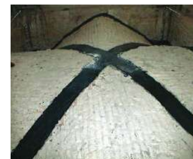
Fig. 7. Meccanismi di danno del pannello murario nel proprio piano.
