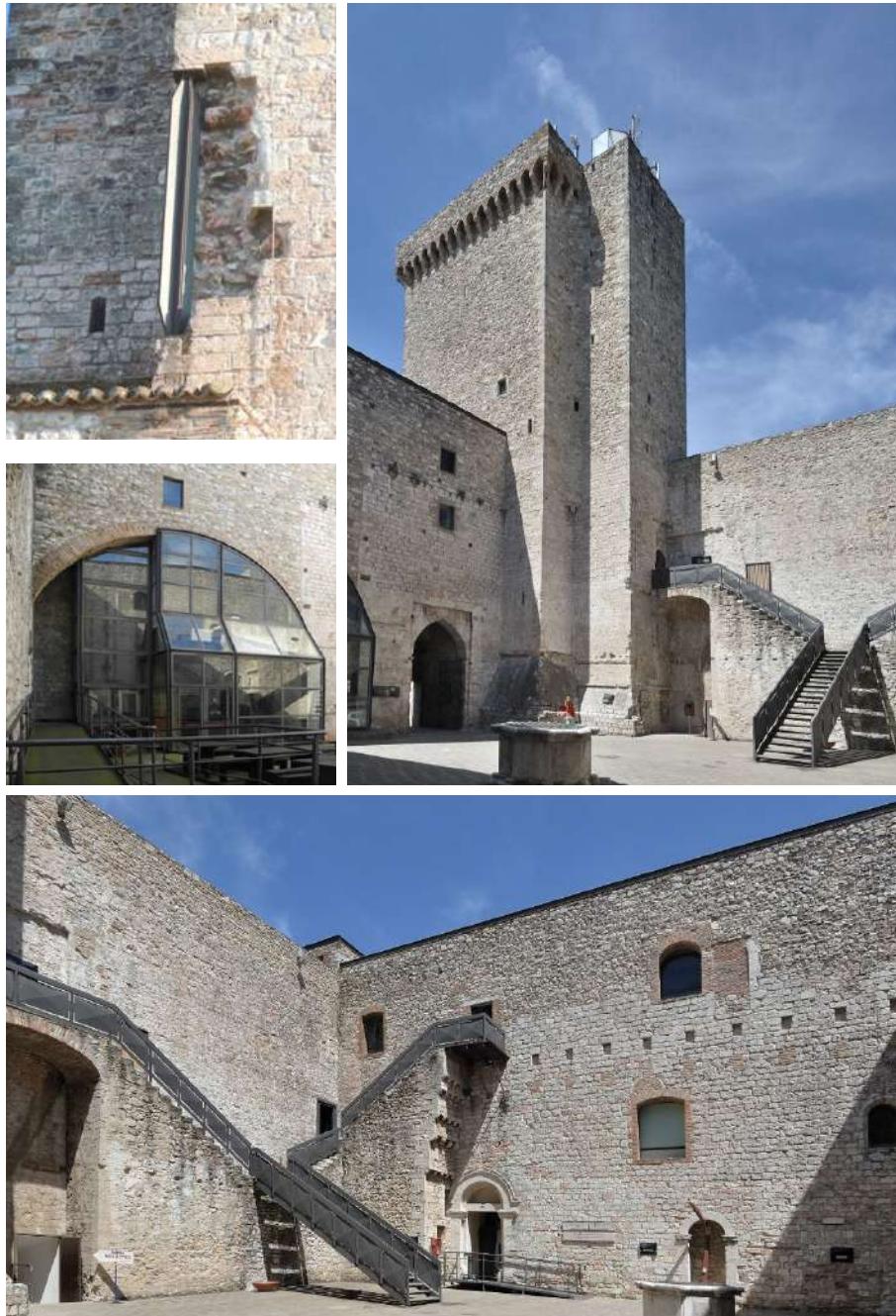
Fig. 1. Narni, Rocca dell'Albornoz, Spoleto, cortile e dettagli di integrazioni architettoniche (scale, sistemi di accesso).
