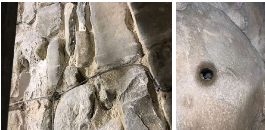
a) Connettore in GFRP inserito nel foro prima del ripristino della ristilatura dei giunti, superficie esterna. b) Reticolatus sul paramento esterno prima della ristilatura dei giunti.
