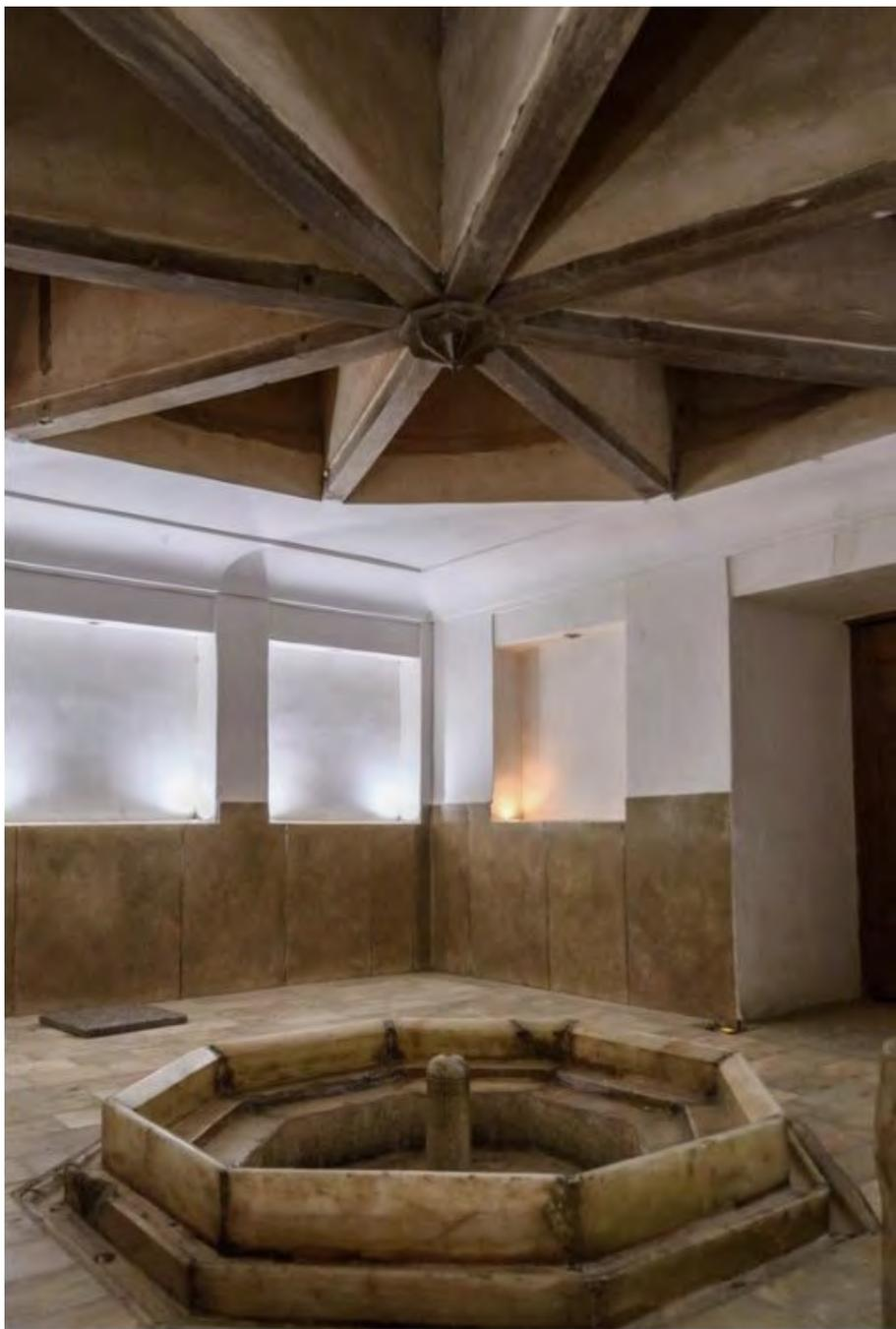
*Fig. 9 b – Yazd. Bagh-e Dolat Abad: interno del padiglione; fontana posta in corrispondenza della base della torre per il raffreddamento dell'aria e degli ambienti.*
